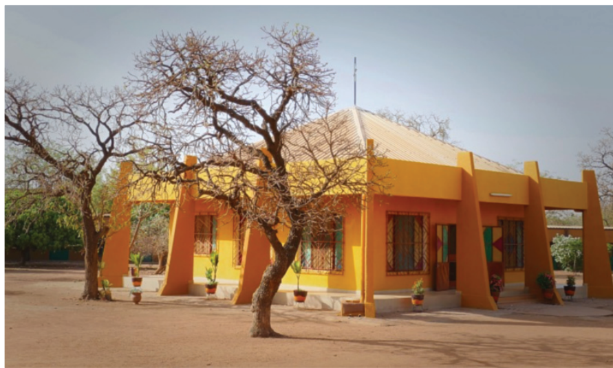
Chapelle de la Maison Lavigerie à Ouagadougou
